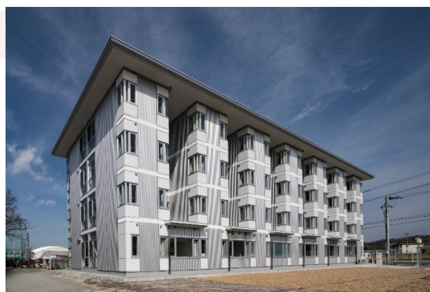
全景(南西より)
