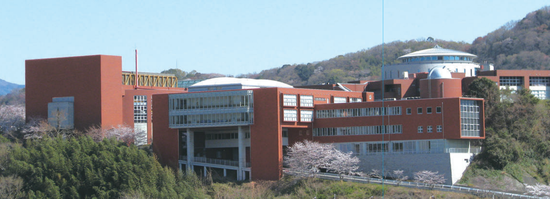
小学校校舎全景
